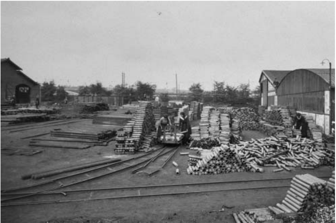
Un double système de voie ferrée irrigue l'entreprise : l'un, classique, raccordé à la gare de triage ; l'autre, en voie étroite à partir du quai de l'Industrie jusqu'aux différents ateliers.
