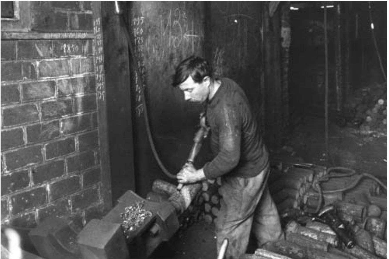
Ebarbage des lopins au marteau-compresseur.
