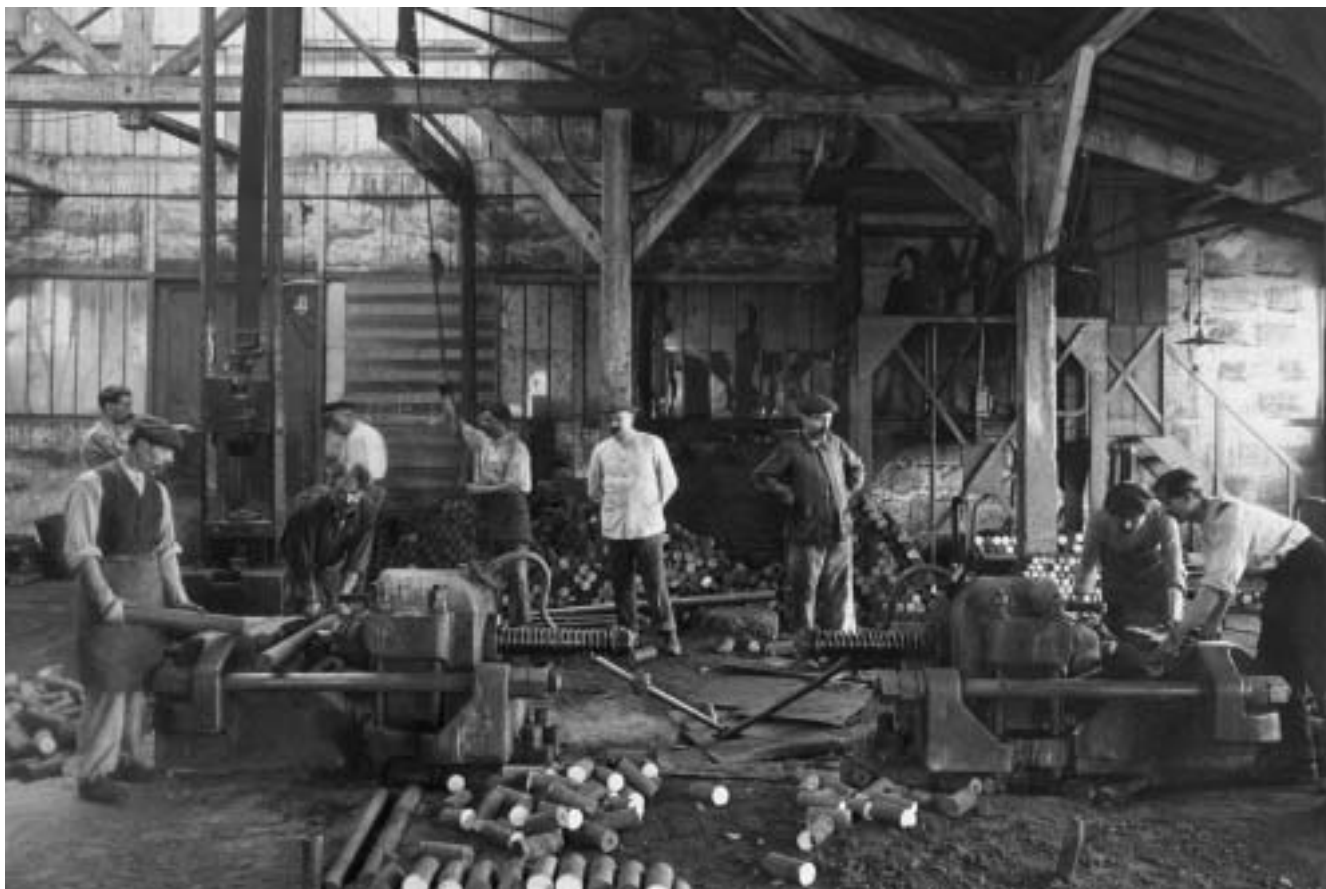
Les grandes barres acheminées par le chemin de fer sont découpées en rondins.
